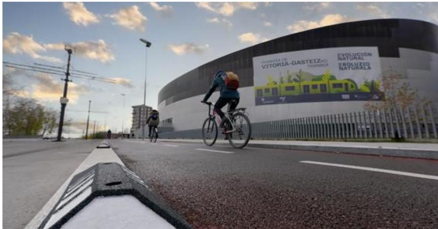
*Figura 3. Elementos de separación en la vía ciclista fabricados mediante caucho reciclado de neumáticos. Fuente: Ayuntamiento de Vitoria-Gasteiz, 2023.*
