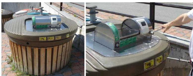
*Figura 2. Contenedores cerrados con un sistema de control volumétrico (calotte) en el Valle de Aosta (Italia). Fuente: Pay for progress Valle Aosta – Italy (WasteinProgress), 2019.*
