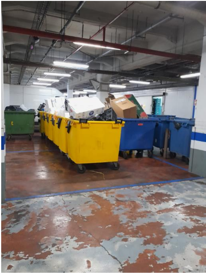
Figura 1. Espacio de acopio de residuos, situado en el aparcamiento subterráneo del mercado. Fuente: EMAYA, 2023.
